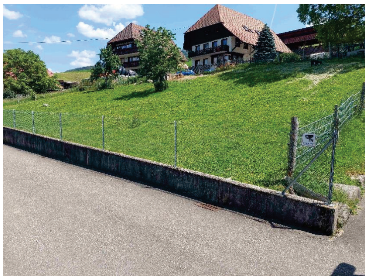
Bild 2: Die Vorhabensfläche mit der durch das Vorhaben beanspruchten Betonmauer, Blick nach Nordosten
