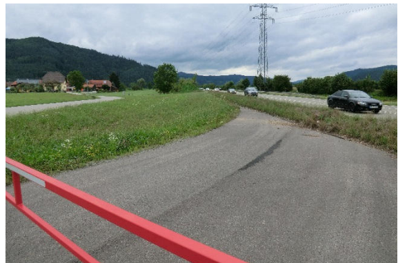
Abb. 4 Bestehende Reste der Behelfsauffahrt, mit Blick auf Lärmschutzwall (Juli 2017).
