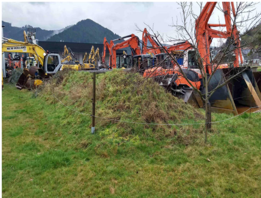
Bild 7: Der nördliche Erdwall (vgl. Maßnahme 4, Punkt 1 sowie Karte 5)
