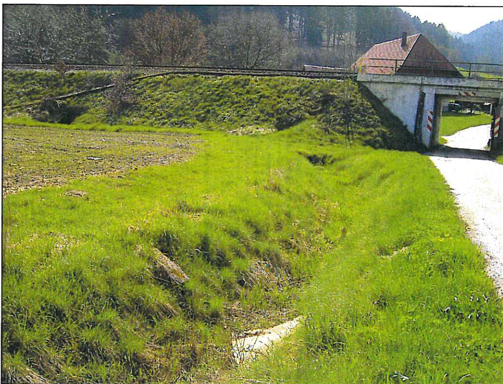
Bild 4: Graben im Nordwesten
