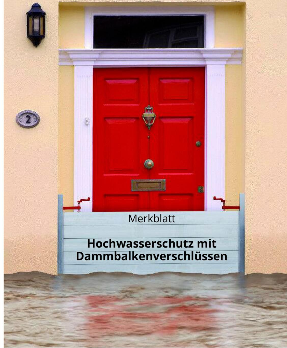
Im Rahmen der Hochwasserschutzmaßnahmen in Welchensteinach wurden bei Ihnen Dammbalkenverschlüsse für eine oder mehrere Gebäudeöffnung/en eingerichtet.
