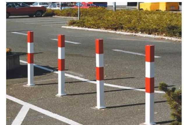
Sperrung mittels Pfosten als Durchlass für Fuß-/Radverkehr
