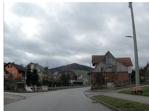
Einleitstelle vom Radweg in den Mischverkehr
