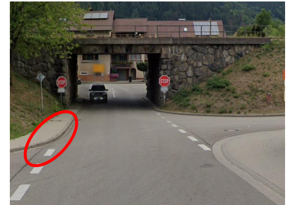
Umbau Hochbord zu Rundbord
