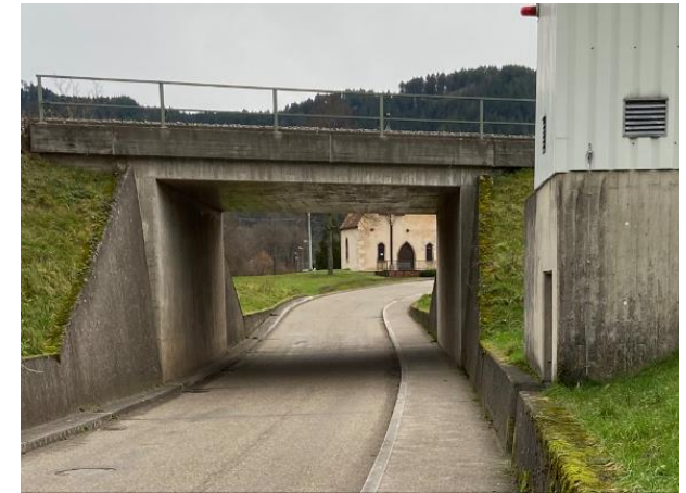
Unterführung Prinzbacher Straße
