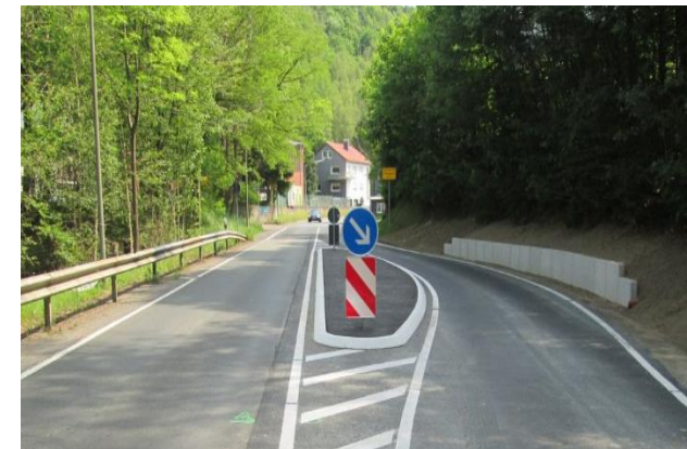
Fahrbahnverschenk am Ortseingang
