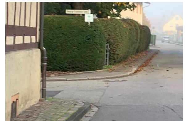
Fehlende Bordsteinabsenkung
